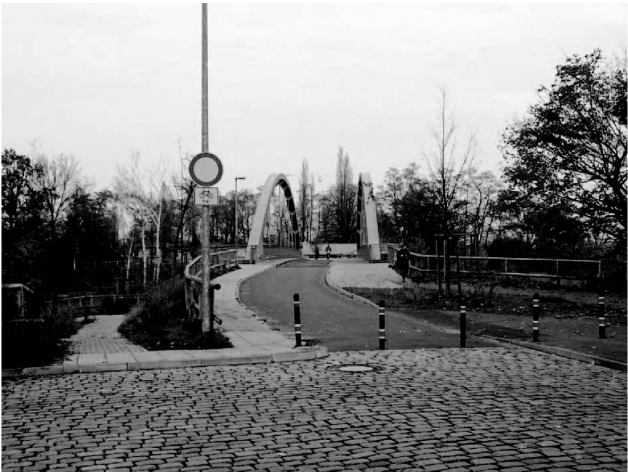
Geh- und Radwegbrücke über den Mittellandkanal
