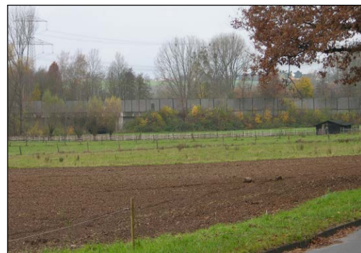
Abb. 5: Lärmschutzanlagen der B 7
