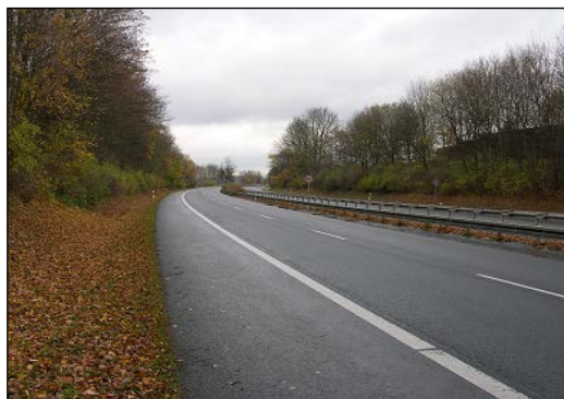
Abb. 4: Vierstreifig ausgebaut B 7
