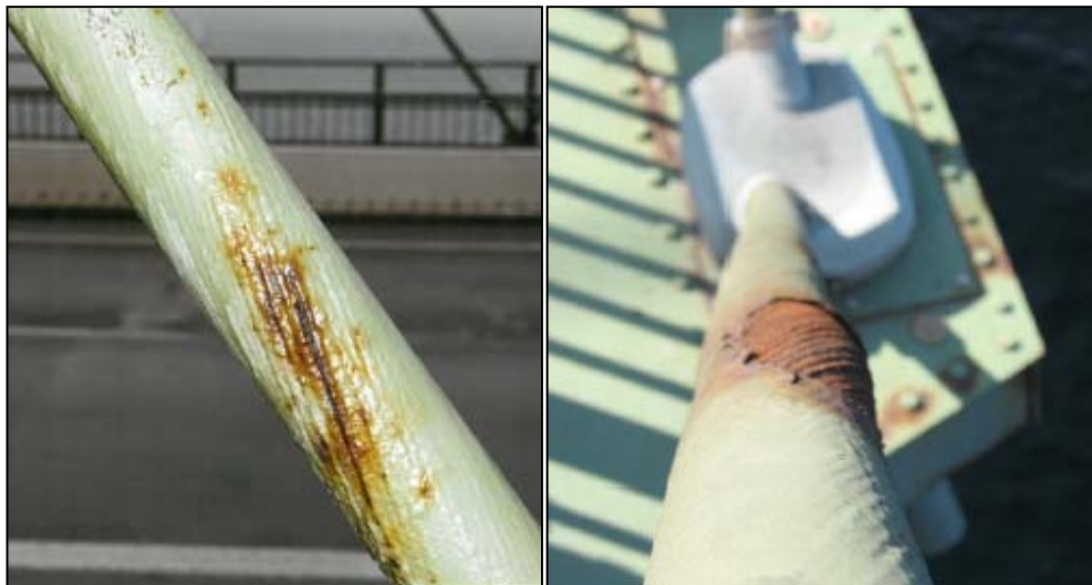
Abbildung 2: Tragseil im Jahr 2000 (links), dasselbe Tragseil im Jahr 2012 (rechts)
