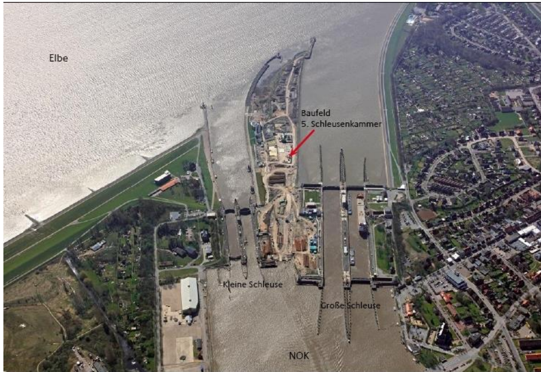
Abbildung: Schleusenanlage Brunsbüttel, Quelle: WSA Brunsbüttel
