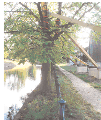
Abbildung 6: Provisorische Sicherung von Bäumen am Landwehrkanal
